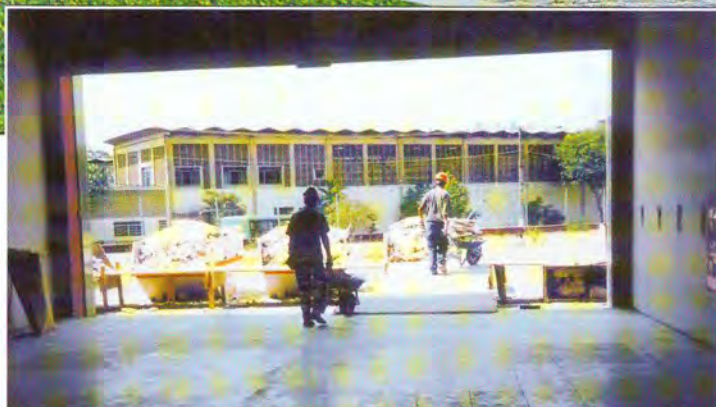
Canteiro de obras: outubro-novembro 2001
