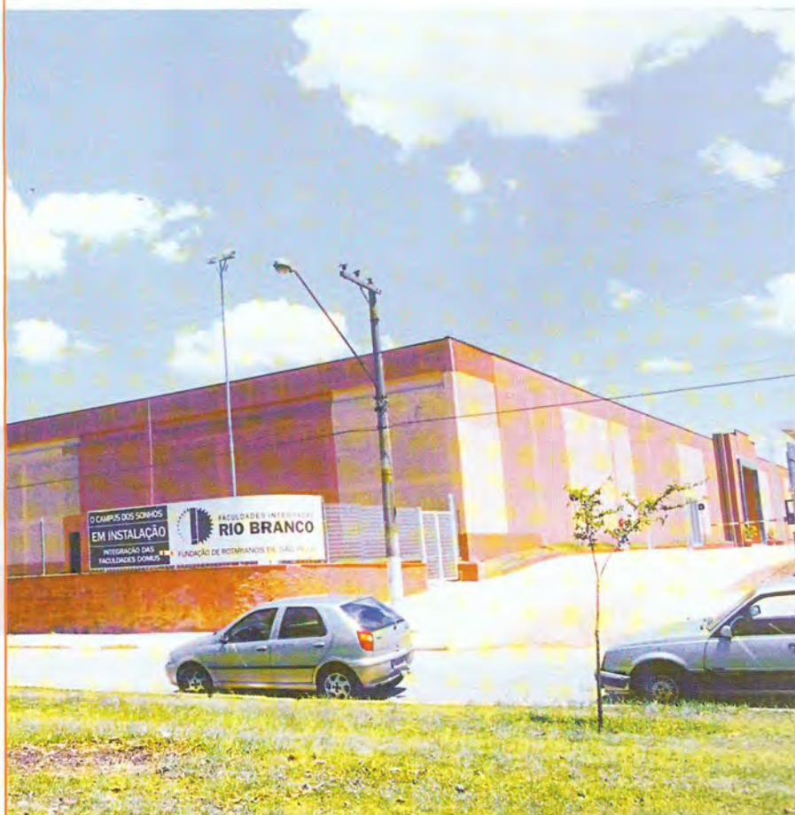
Faculdades Integradas Rio Branco em fase de instalação
